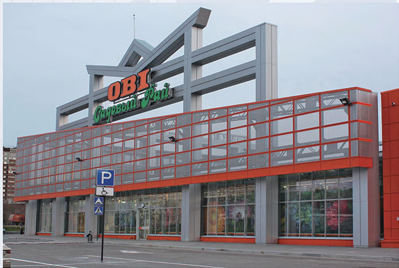
ТЦ «ОБИ-Садовый рай» на ул. Халтурина г. Екатеринбург (2010 г) - вентфасады, декоративные конструкции, колонны и перфорированные экраны. Металл - алюминий толщиной 2,0 мм с покрытием PVDF.
