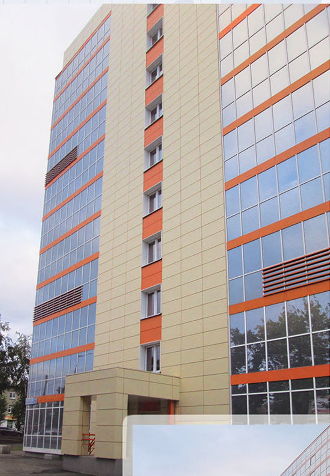
Общежитие УРФУ г. Екатеринбург (2013 г) - кассеты и фасадные решетки из оцинкованной стали толщиной 1,0 мм
