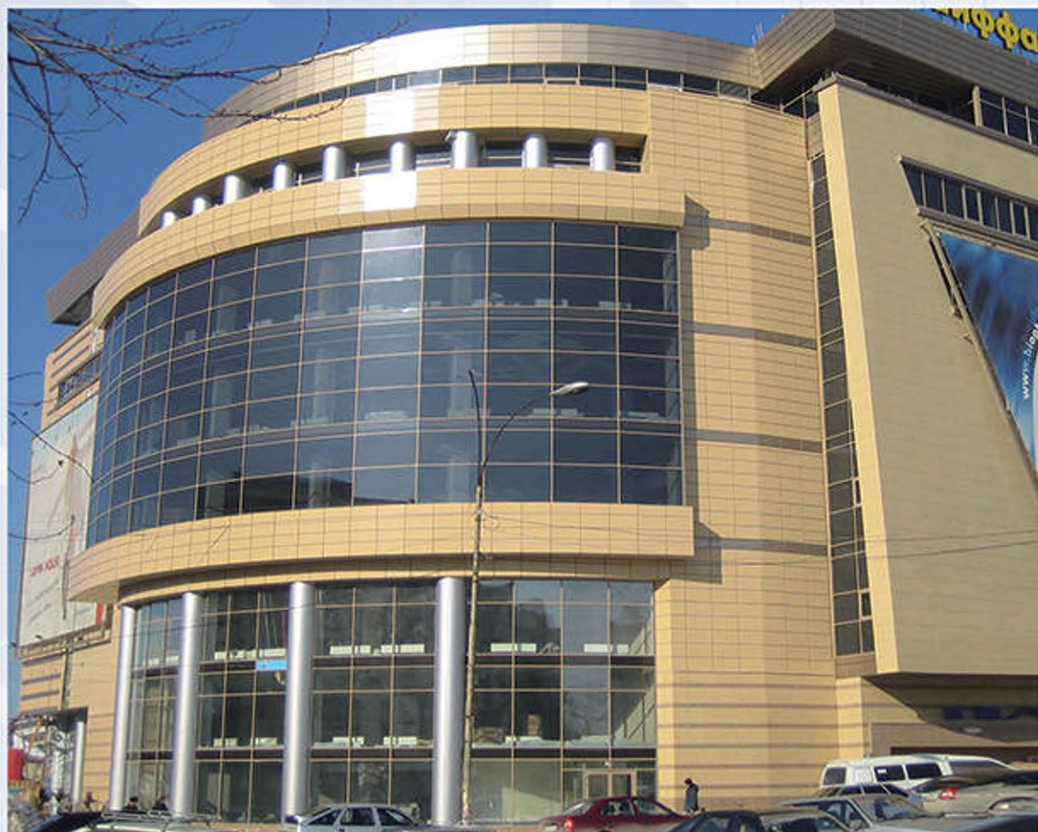
ТРЦ «Антей» 2-я очередь г. Екатеринбург (2005 г) - вентфасад, колонны - оцинкованная сталь 1,2 мм с покрытием PVDF.
