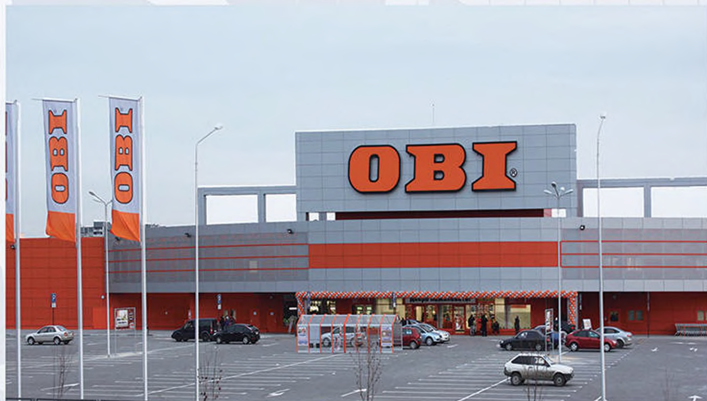
ТЦ «OBI» и «OBI-Садовый Рай» на ул. Халтурина г. Екатеринбург (2010 г) - вентфасады, декоративные конструкции, колонны и перфорированные экраны. Металл - алюминий толщиной 2,0 мм с покрытием PVDF.
