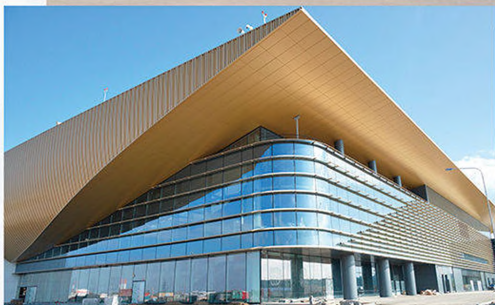
Аэропорт Перми (2017 г) Металл - алюминий толщиной 2.0 мм с полимерным покрытием производства "Impol-Seval" (Сербия).
