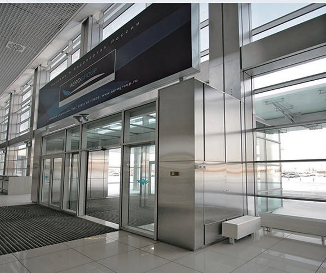
Аэропорт Кольцово г. Екатеринбург (2006-2009 г) - производство и монтаж металлической облицовки ригелей и входных групп. Металл - сталь нержавеющая шлифованная 1,0 мм
