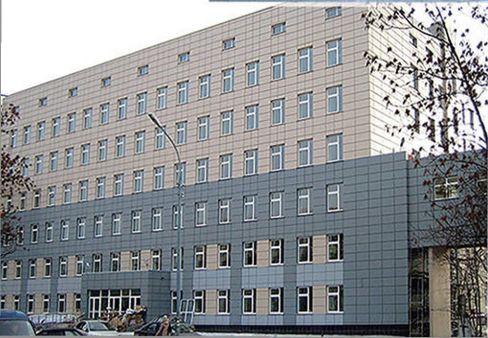
Диагностический центр г. Екатеринбург (2006 г) - вентфасад - оцинкованная сталь 1,2 мм с покрытием PVDF
