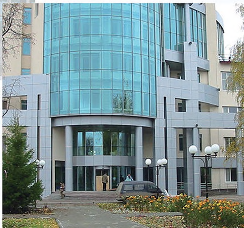
УГМК-холдинг, г. Верхняя Пышма (2005 г) - входная группа главного офиса, алюминиевый композит.
