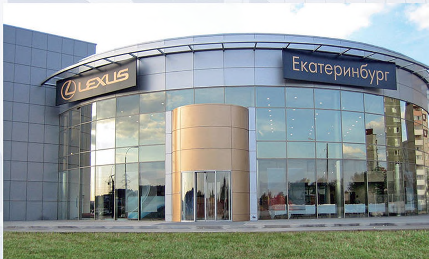
Автоцентр «Лексус» г. Екатеринбург (2006 г) - вентфасад - оцинкованная сталь 1,2 мм с покрытием PVDF
