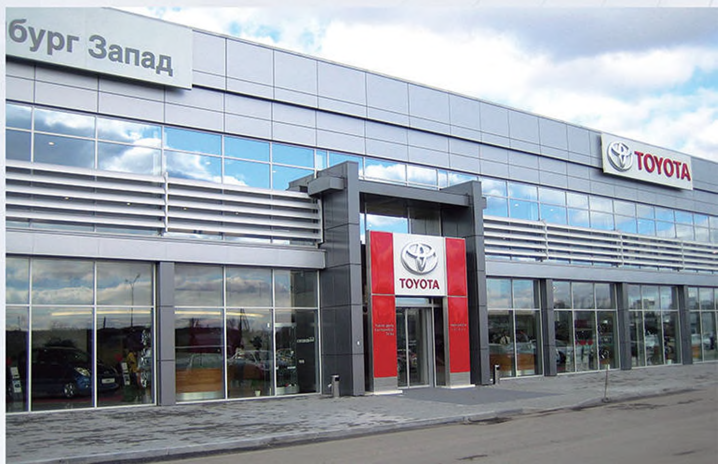
Автоцентр «Тойота Центр Екатеринбург Запад» г. Екатеринбург (2006 г) - вентфасад - оцинкованная сталь 1,2 мм с покрытием PVDF
