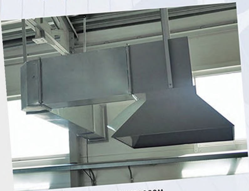
Вытяжка с воздуховодом
