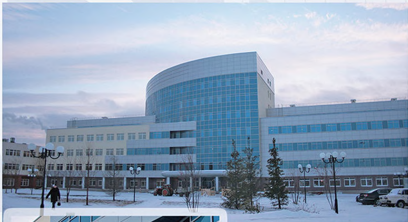
УГМК - инженерный корпус, г. Верхняя Пышма (2006 г) - вентфасад - оцинкованная сталь 1,2 мм с покрытием PVDF, - козырек - алюминий 2,0 мм с покрытием PVDF.
