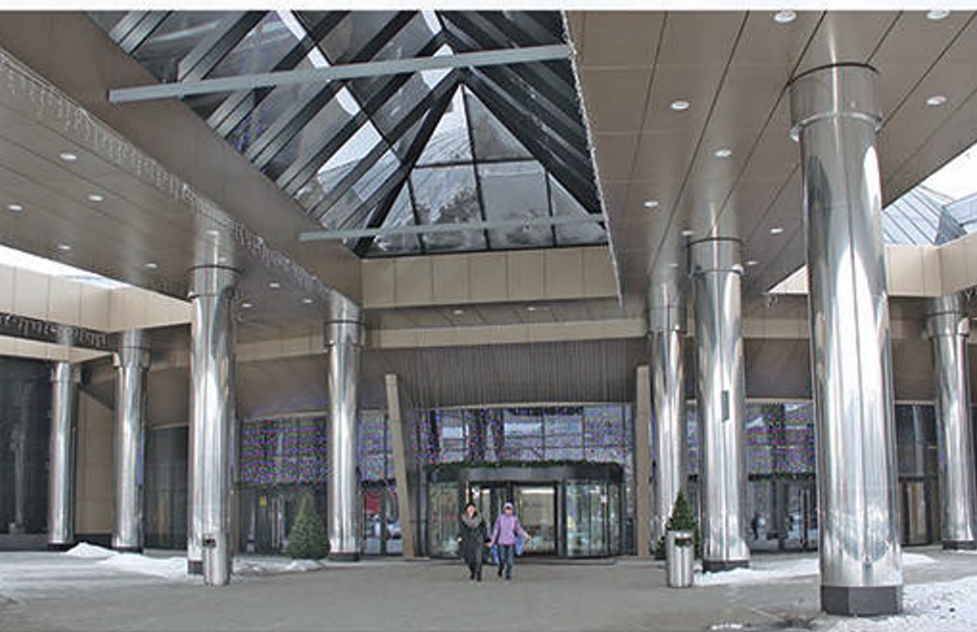
Облицовка колонн, стен, потолков
