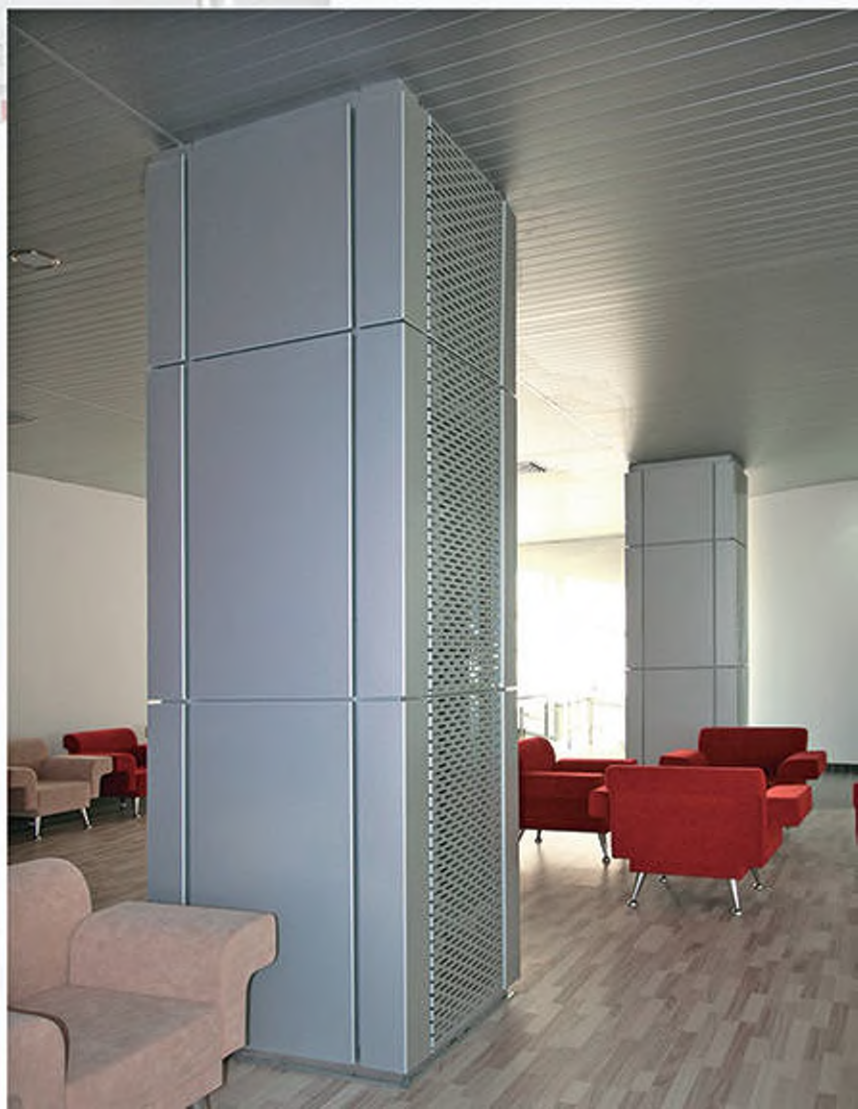
Автоцентр HONDA, г. Челябинск (2008 г) - облицовка колонн с перфори- рованными элементами и подсветкой. Металл - алюминий 2,0 мм с полимерным покрытием.
