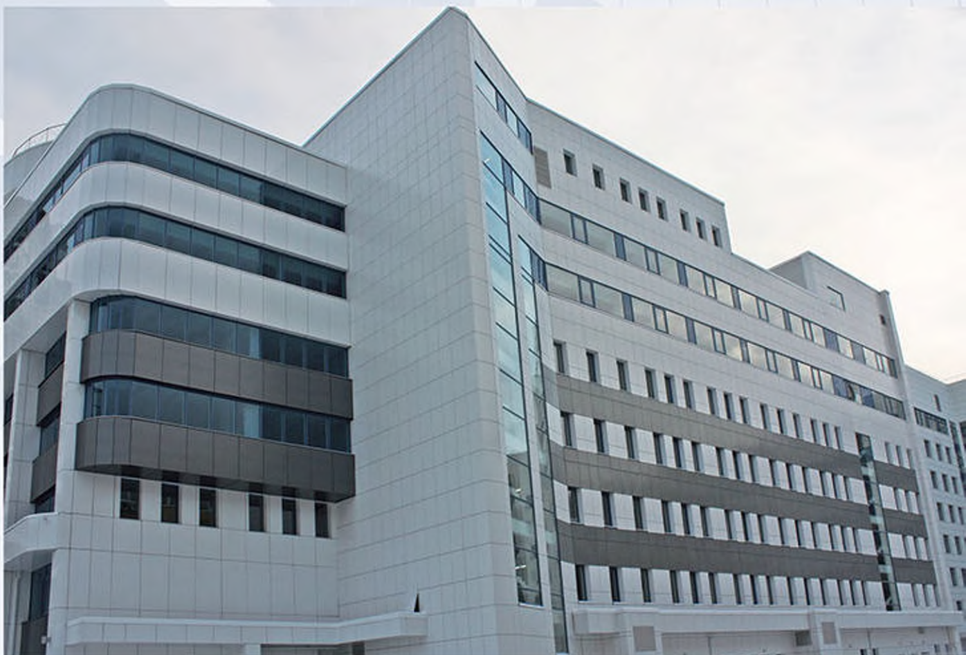
Сбербанк на ул. Гоголя г. Екатеринбург (2012 г) - правая часть вентфасада (торцевая) - алюминиевый композит - левая часть фасада (фронтальная) - оцинкованная сталь 1,2 мм с полимерным покрытием
