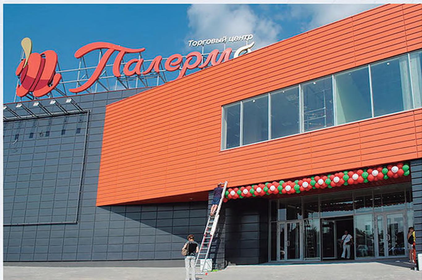
ТЦ «Палермо» г. Полевской (2014 г) - вентфасад - оцинкованная сталь 1,0 мм с полимерным и полимерно-порошковым покрытием.
