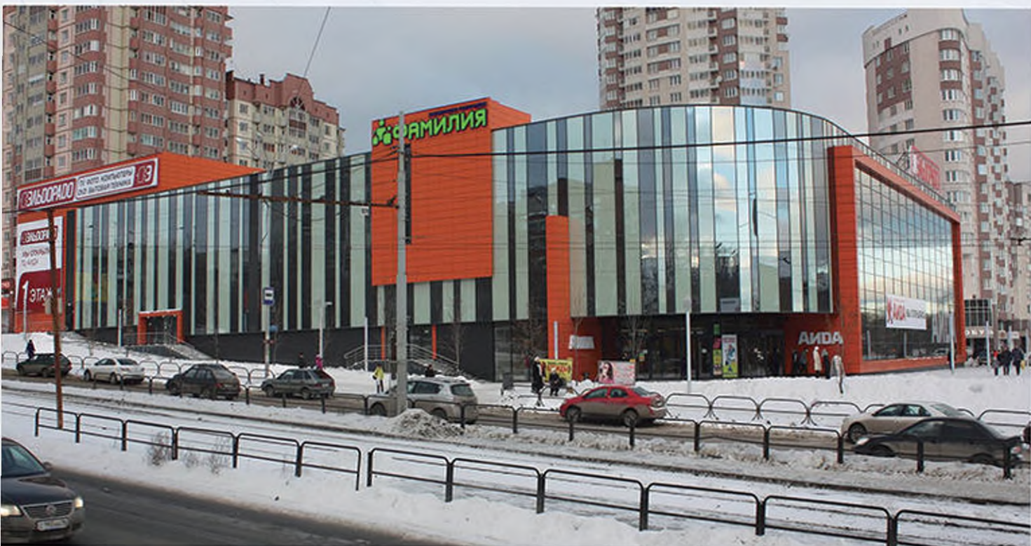
ТЦ «Аида» г. Екатеринбург (2012 г) - металлокассеты - оцинкованная сталь 1,2 мм с полимерным покрытием.
