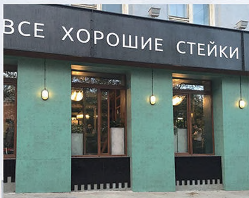
Ресторан "Угли", Екатеринбург (2016 г). - облицовка вентфасада. Металл - алюминий толщиной 0,8 мм с полимерным покрытием под патиниро- ванную медь.
