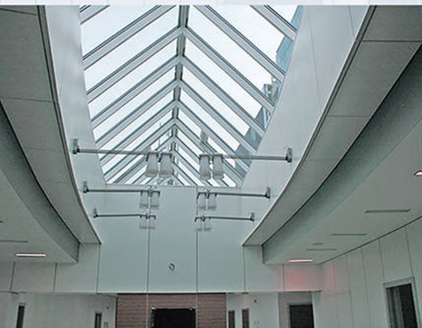
Облицовка стен и потолка
