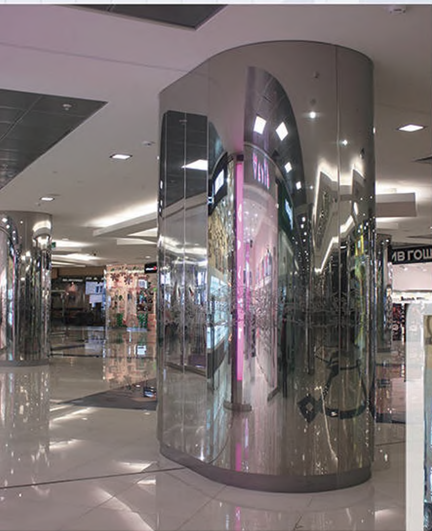
ТРЦ «Алатырь» г. Екатеринбург (2011 г) - облицовка колонн и лифтовых порталов - полированная нержавеющая сталь 1.0 мм. Декоративный узор нанесен способом пескоструйной обработки.
