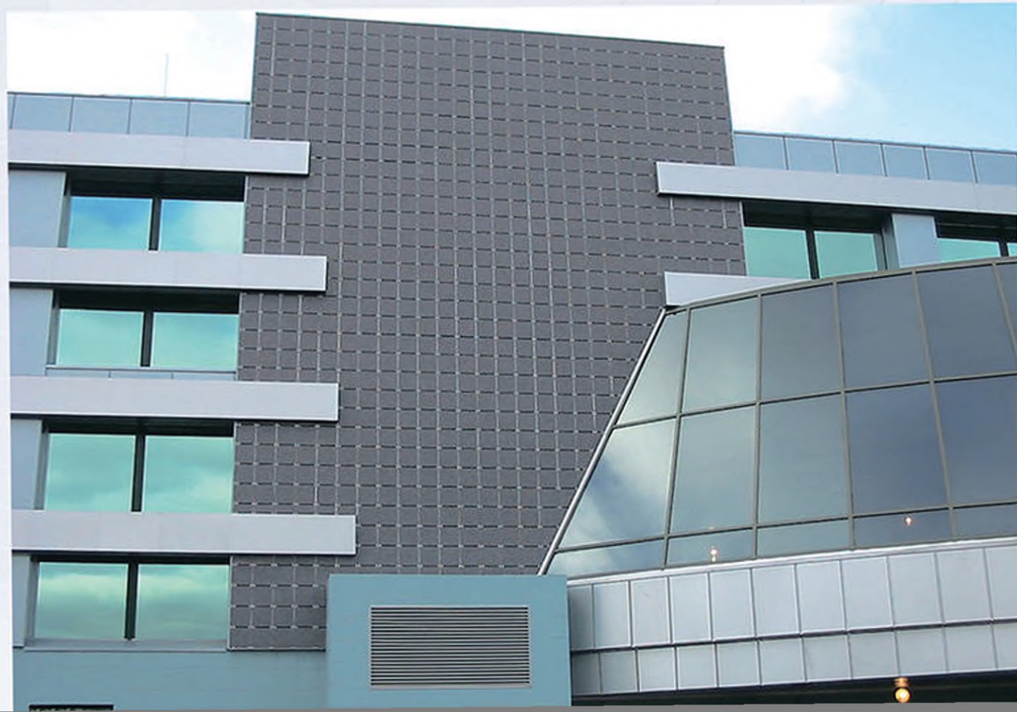
РЦ «Мегаполис» г. Челябинск (2005 г) - вентфасад - оцинкованная сталь 1,2 мм с покрытием PVDF, керамогранит
