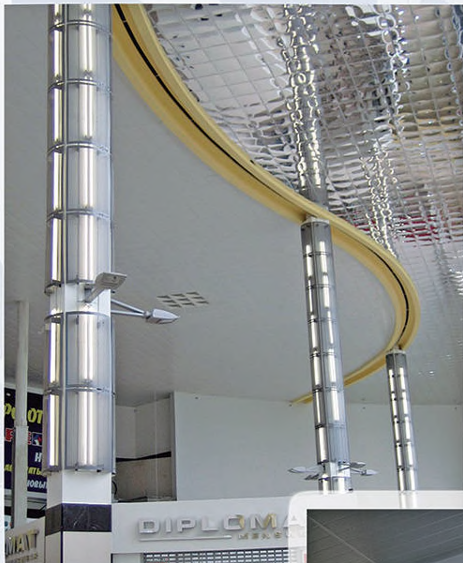
ТРЦ «Гринвич» 1-я очередь г. Екатеринбург (2006 г) - перфорированная облицовка для декоративных колонн с подсветкой. Металл - оцинкованная сталь с полимерным покрытием.
