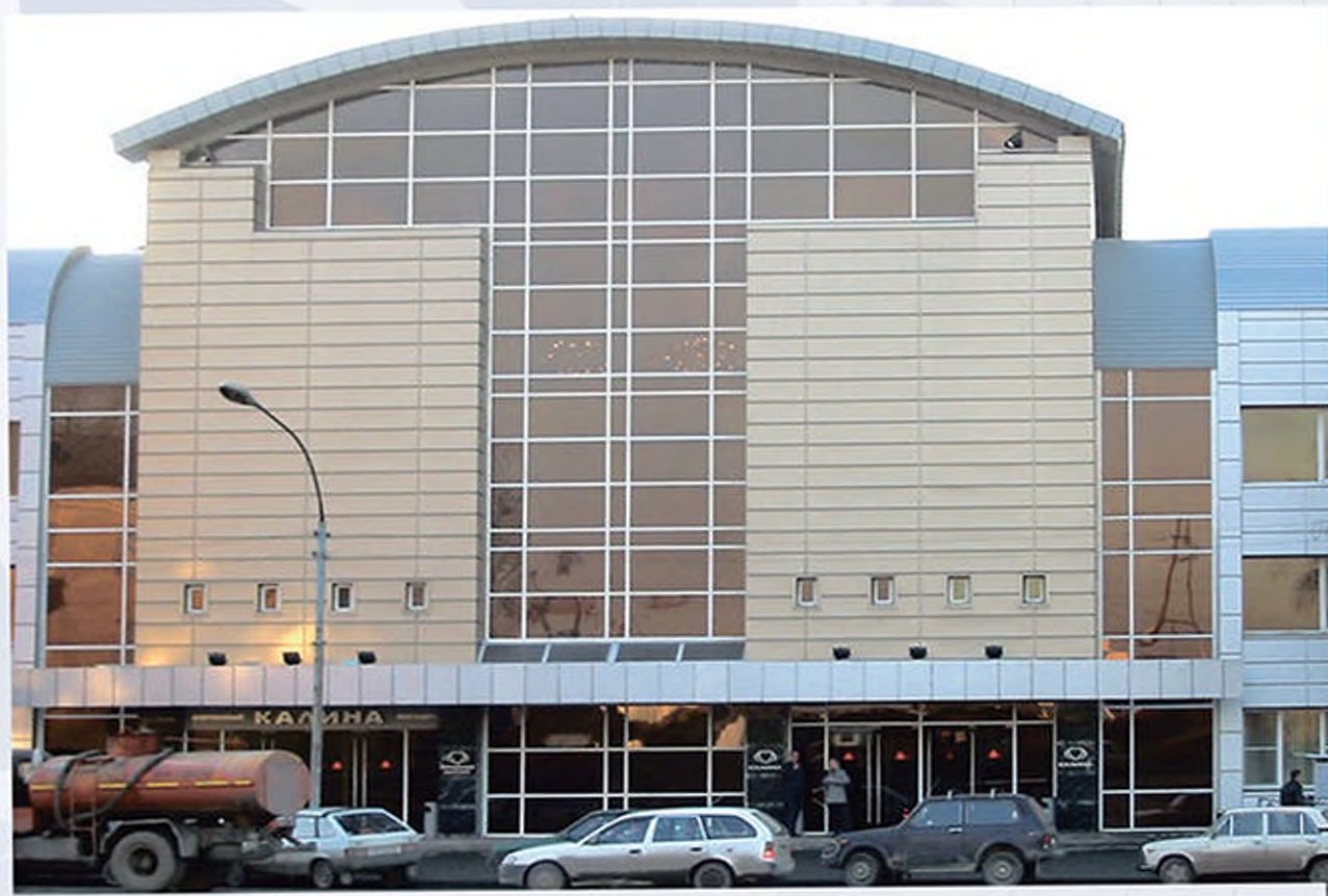
Концерт «Калина» - административный корпус (2005 г) - вентфасад - оцинкованная сталь 1,2 мм с покрытием PVDF.
