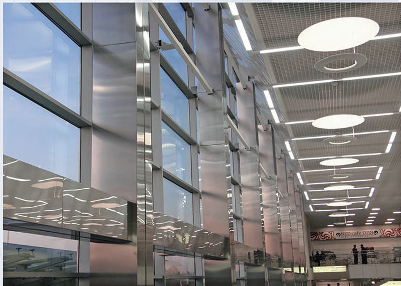
Аэропорт Кольцово г. Екатеринбург (2006-2009 г) - производство и монтаж металлической облицовки ригелей и входных групп. Металл - сталь нержавеющая шлифованная 1,0 мм
