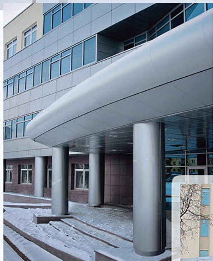
УГМК - инженерный корпус, г. Верхняя Пышма (2006 г) - вентфасад - оцинкованная сталь 1,2 мм с покрытием PVDF, - козырек - алюминий 2,0 мм с покрытием PVDF.
