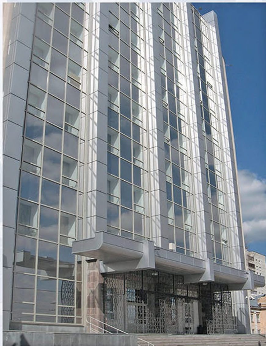
Управление Банка России г. Екатеринбург (2003 г) - облицовка металлом фасада и козырька. Металл – оцинкованная сталь 1.2 мм с покрытием PVDF.
