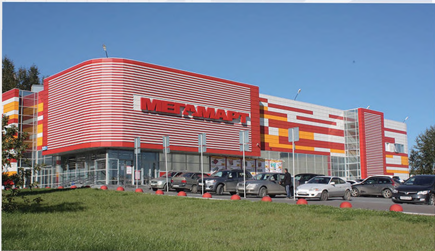
Супермаркет «Мегамарт» на ул. Ткачей г. Екатеринбург (2013 г) - вентфасад - кассеты из стали 1,0 мм с порошковой окраской.
