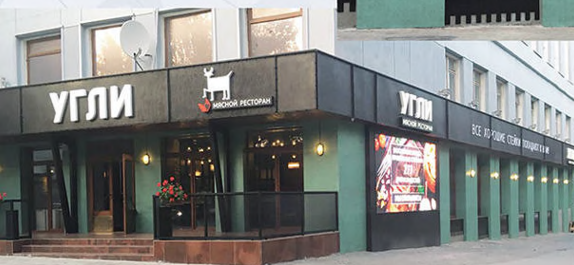
Ресторан "Угли", Екатеринбург (2016 г). - облицовка вентфасада. Металл - алюминий толщиной 0,8 мм с полимерным покрытием под патиниро- ванную медь.
